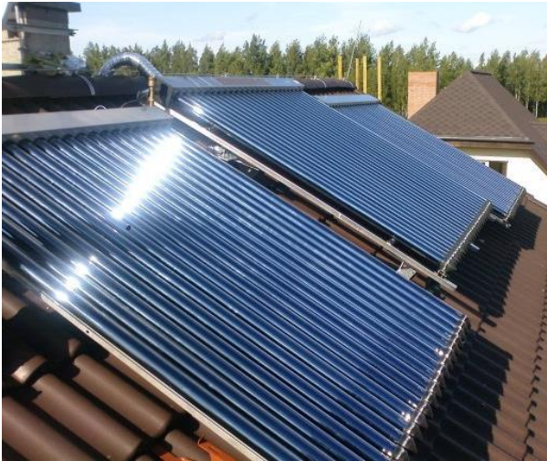
Նկ. 10. Թեք տանիքին արևային կոլեկտորի տեղադրման օրինակ
